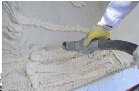
Die spritzbare Hochleistungsdämmung Ecosphere in der Anwendung.
