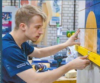
Foto: © KUNZEL Bau/Bahn
