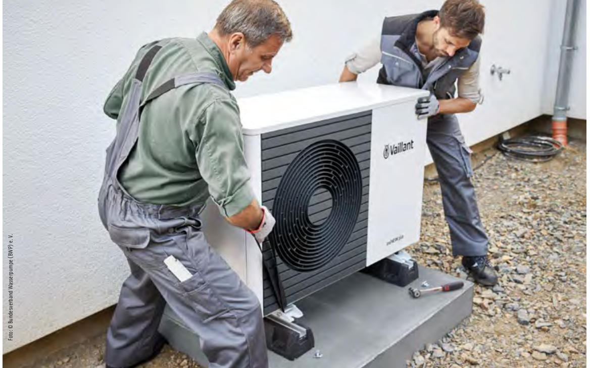
Fachmännische Installation einer Wärmepumpe
