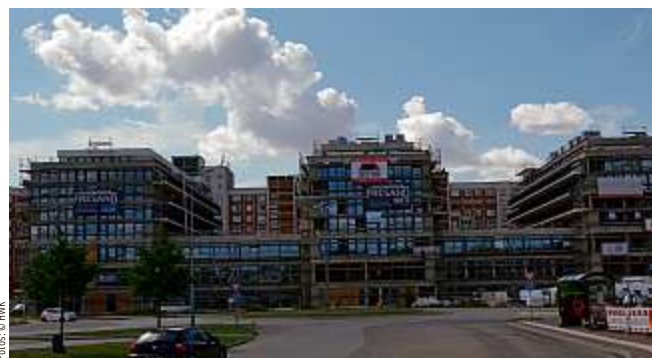
Nicht nur in Rostock ist derzeit der Rostocker Dachdeckerbetrieb tätig.
