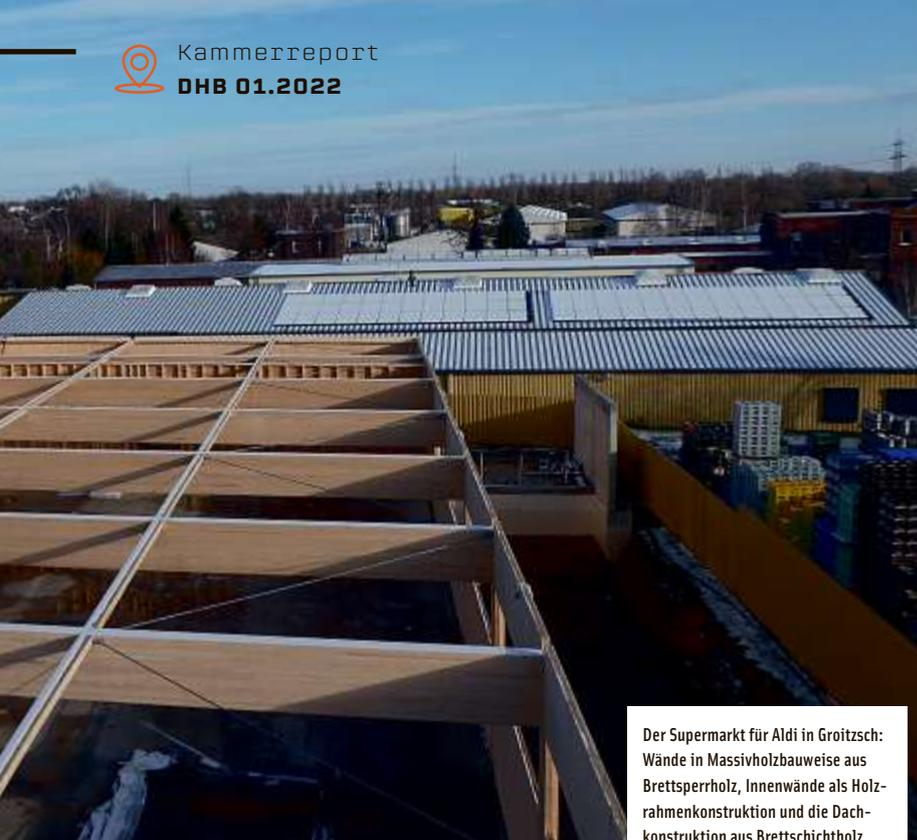
Der Supermarkt für Aldi in Groitzsch: Wände in Massivholzbauweise aus Brettspertholz, Innenwände als Holzrahmenkonstruktion und die Dachkonstruktion aus Brettschichtholz.
